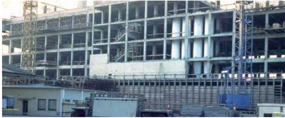
Das gesamte Gebäude durchzieht ein regalartiges (5x8x4,6 Meter ) Stahlbetonraster, das wir für den Innenausbau nutzen können. Die Fassade erfüllt keine tragende Funktion und kann daher ausgetauscht werden.
